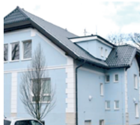
Denní stacionář byl vybudován v objektu bývalé školky ve Smetanově ulici.
